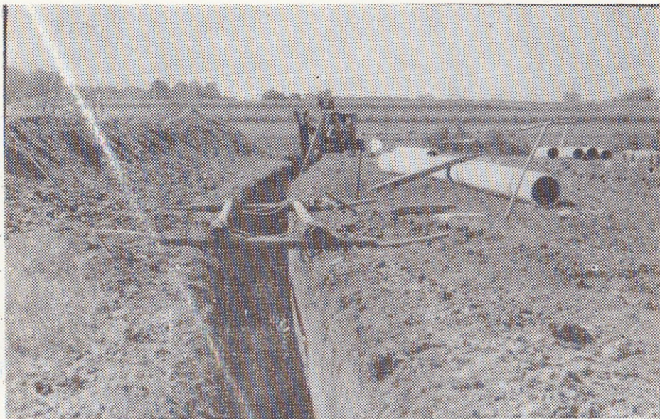
Épül a 10,1 km hosszú NA 400-as távvezeték
