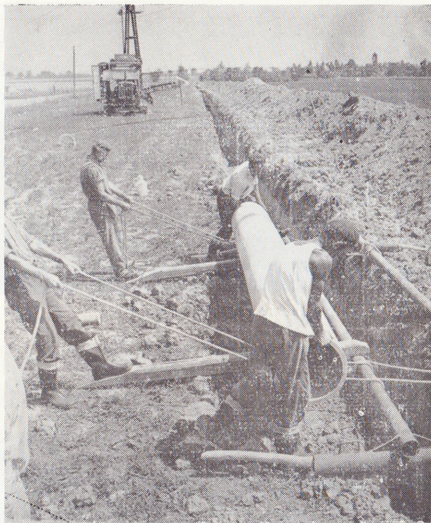
Kenéz határában feltetik az NA 409-as távvezetékét
